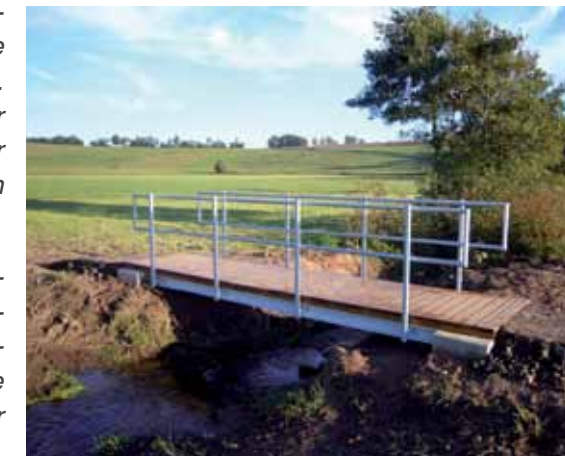
Brücke über den Oosbach nach Fertigstellung.
